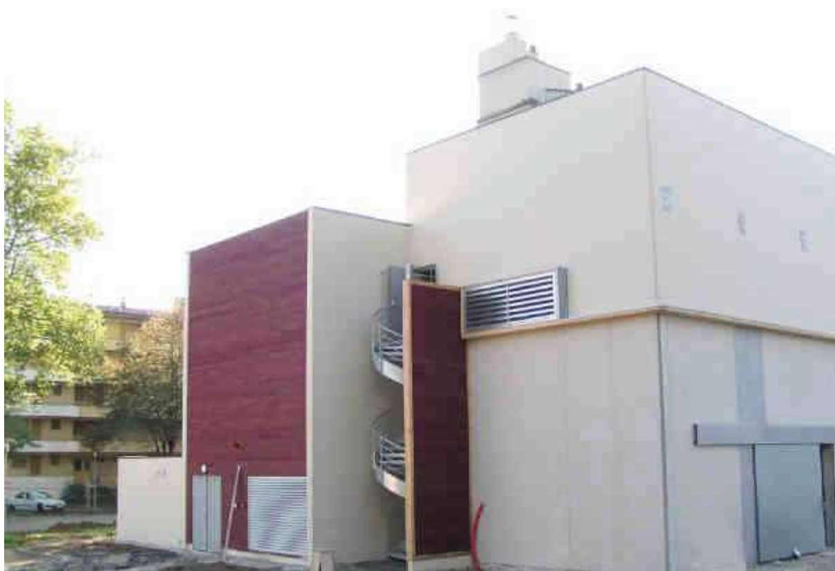
Chaufferie bois – Bourg en Bresse – Ain (01)
