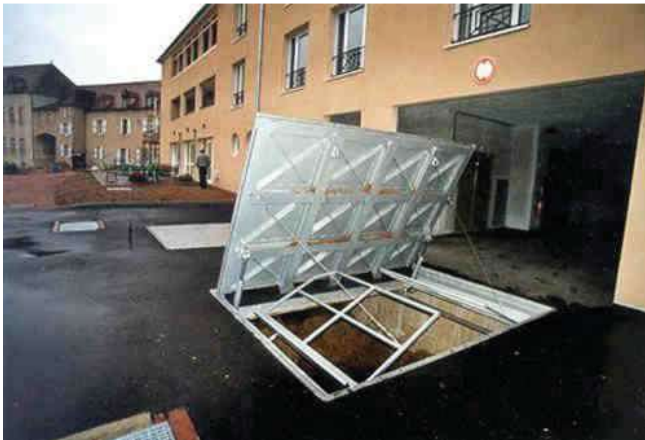
Silo maçonné enterré pour déchargement direct avec trappes carrossables
