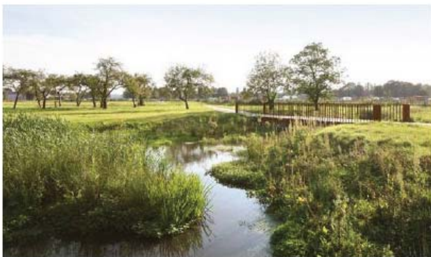
Bassin paysager aux formes douces et berges végétales
